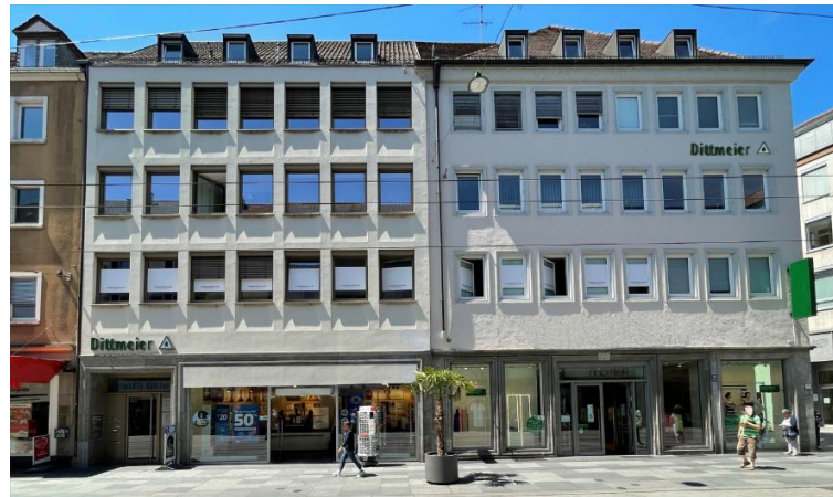
Abbildung 3: Eingang zur Kaiserstr. 23 (2., 3., 4. u. 5. OG + Keller und Hoffläche)
