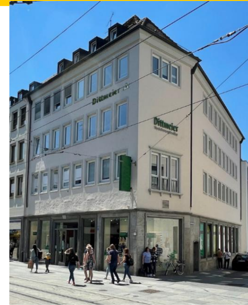
Abbildung 4: Seiteneingang zur Kaiserstr. 25 (2., 3., u. 4. OG)
